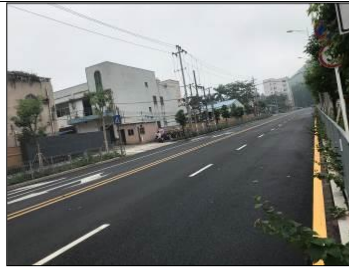
项目西侧李松萌炮台路
