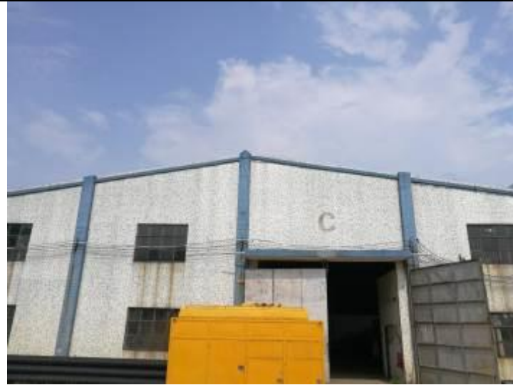
项目东侧工业厂房
